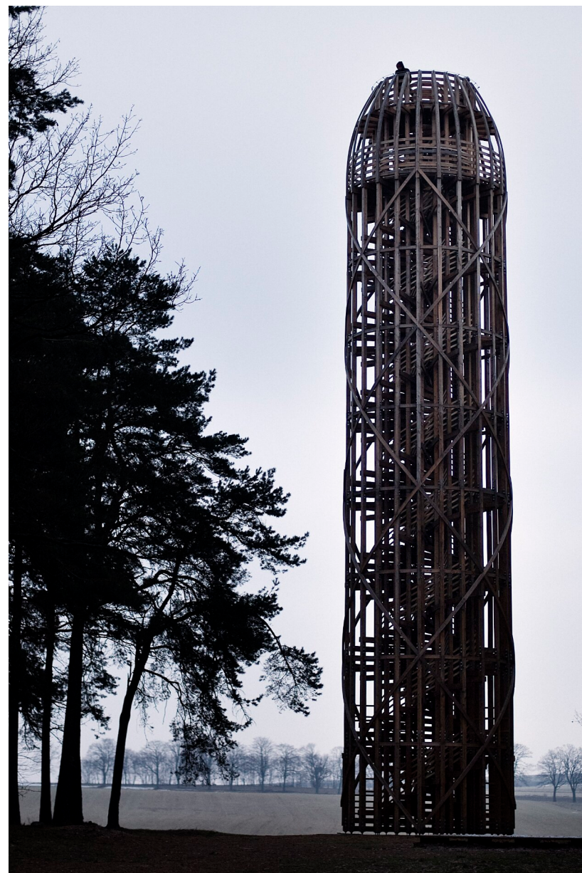
Referenční stavba, rozhledna Vokurka Heřmanice u Frýdlantu
